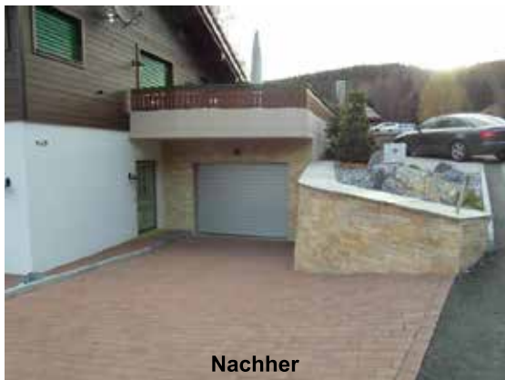
Sichtschutz und Zaunbau
